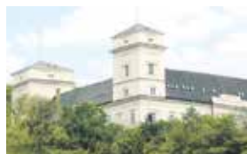
Zámek Račice, přestavba
