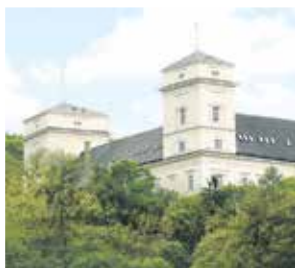
Zámek Račice, přestavba
