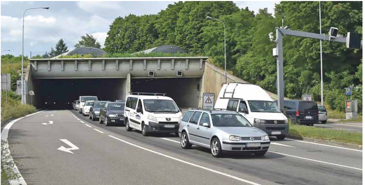
Ředitelství silnic a dálnic plánuje na dva měsíce uzavřít Husovický tunel. Řidiči by se sem měli vrátit na konci srpna. Foto: Z. Kolařík
