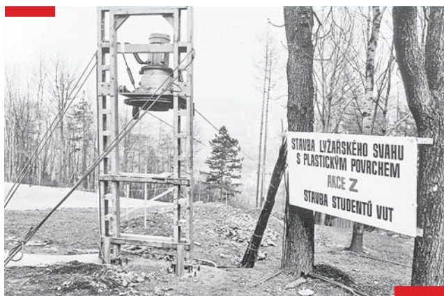
Snímek z roku 1973, kdy se na sjezdovce dělaly úpravy, stavěl se vlek a budovalo osvětlení. Foto: archiv MB
