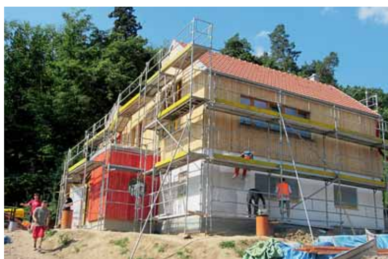
▲ Při stavbě ekodomu v Jundrově byly využity šetrné technologie a materiály. Foto: Lipka
