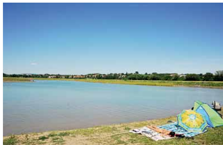
▲ Rybám vstup zakázán. V roce 2013 byl s podporou evropských fondů uskutečněn projekt Biocentrum Chrlice. Zahrnuje výstavbu vodní nádrže o rozloze čtyři hektary a průměrné hloubce tři metry, která je napájena podzemní vodou a vybavena přítokovým objektem napojeným na Ivanovický potok, dále vybudování tří zpevněných polních cest a ozelenění okolí stromy a keři. Evropská dotace nepřípouští využití nádrže k chovu ryb a sportovnímu rybolovu, na plavání a slunění se zákaz zřejmě nevztahuje.
