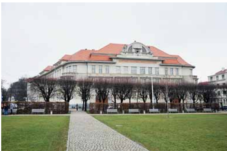
Siluetu školy, mansardová střecha a osový štít připomínají barokní budovu, ale detaily evokují spíše modernu s kubistickými prvky. Foto: Z. Kolařík
