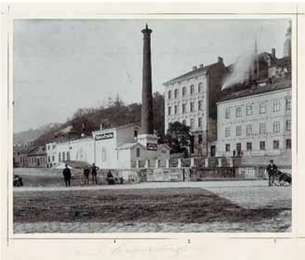
Snímek pořídil cca před sto lety pro městský stavební úřad fotograf, který sice neměl Silniční ulici před objektivem, ale stál na jejím rozhraní s Novými Sady a zachoval pro nás památku na městské sprchové lázně na sousední Kopečné ulici.
