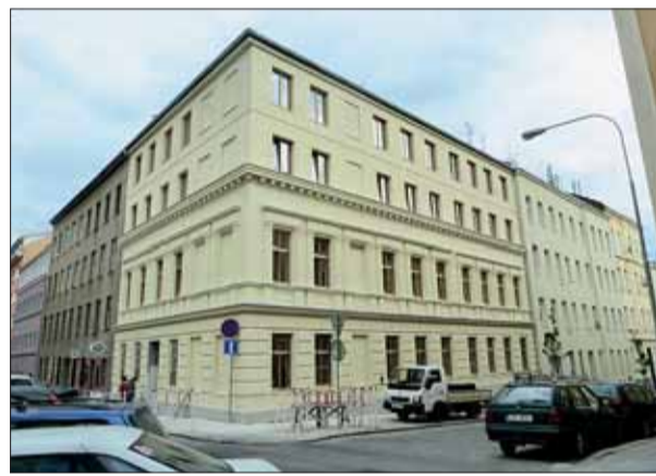
■ ...a stav dnešní. Dům byl kompletně zrenovován a přibýlo tu 6 nových bytů v nástavbě. Foto: archiv MMB
