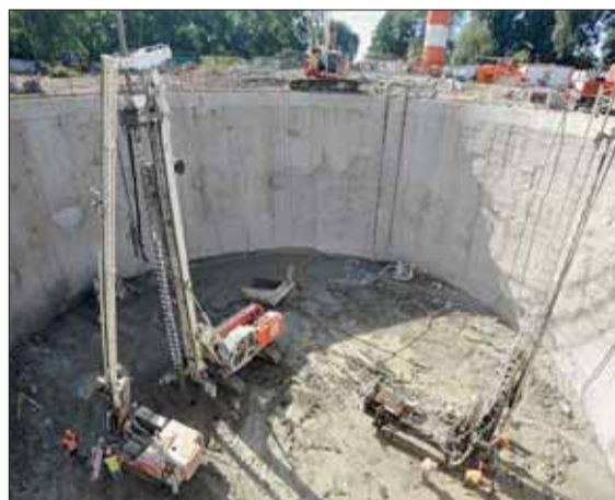
▲ Září 2011. Po injektáži zajišťující celou stavbu začali stavbaři s betonováním budoucího dna nádrže.
