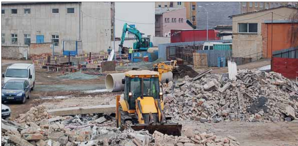
▲ Březen 2011. Náročnou akci provádí pro Brno sdružení stavebních firem. Jejich pracovníci si nejprve museli udělat místo pro vlastní stavbu. Zbourali letité nevhodné garáže a provizorní ubytovnu a pomocí techniky odstranili sutiny.
