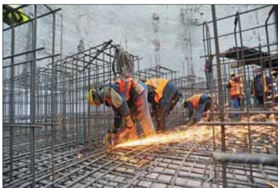
▲ Prosinec 2011. Práce pokračovaly i v zimě. Po svaření výztuží pro budoucí železobetonovou stavbu bylo zapotřebí doladit sváry.
