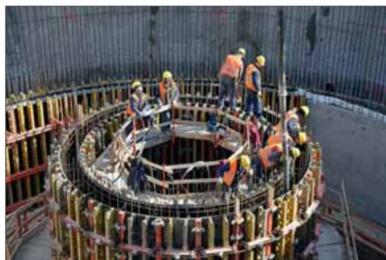
▲ Leden 2012. Zárodek vnitřní nádrže o objemu 4 tisíce krychlových metrů. Vnější nádrž pojme 4600 kubiků kanalizační a splaškové vody.
