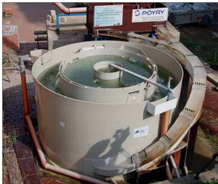
▲ Rok 2010. Ještě před zahájením stavby vytvořili specialisté z VUT v Brně ve spolupráci s dalšími odborníky fyzikální model stavby v měřítku 1 : 10. Po jeho napuštění inženýři zaznamenávali a hodnotili hydraulické jevy. Celý systém také ověřovali pomocí matematického modelování.
