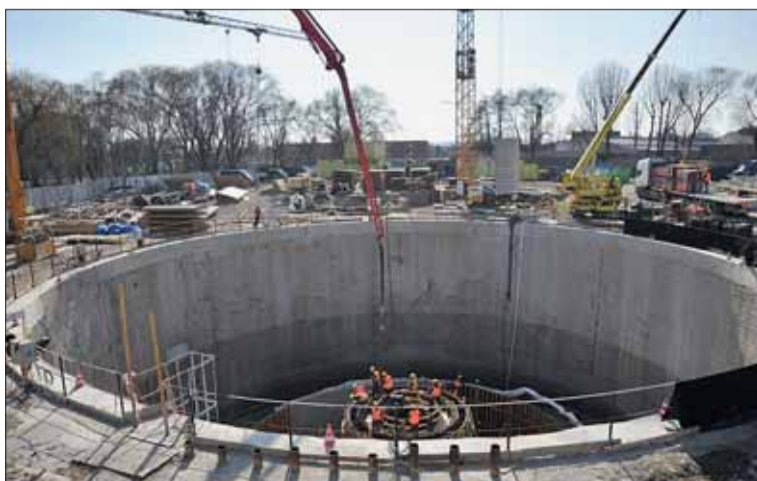
▲ Prosinec 2011. Práce pokračovaly i v zimě. Po svaření výztuží pro budoucí železobetonovou stavbu bylo zapotřebí doladit sváry.
