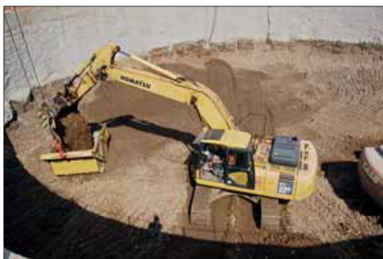
▲ Červenec 2011. Bagry postupně odtěžily jíly a štěrko-pískové naplaveniny, které pomocí drapáku jeřáb přepravil na úroveň povrchu. V polovině loňského července bylo vyhloubeno sedm metrů. Celkové množství vytěžené zeminy pro stavbu nádrže bylo 26 tisíc krychlových metrů.
