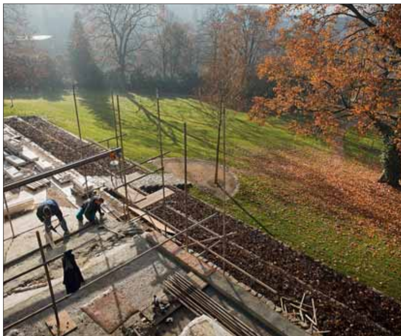
Sanaci prošly ty konstrukce domu, které byly příčinou opakovaných havarijních situací – izolace, kanalizace, zdravotnické instalace, elektroinstalace, výměňková stanice. Opravena a staticky zajištěna byla i zahradní terasa se schodištěm.
