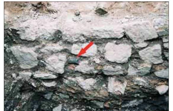
► Detail zdiva kostela sv. Prokopa se zazděným okrajem zásobnice. Fota: archiv Archaia Brno
