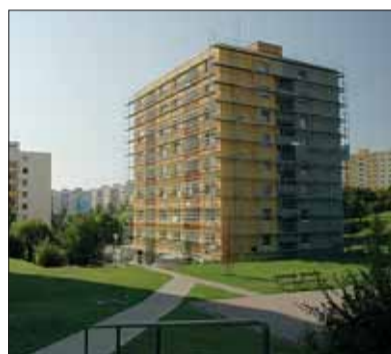
Regenerace „paneláků“ (např. v Bystřici) se vyplácí. I díky tomu tu chce více než polovina obyvatel sídliště zůstat.
