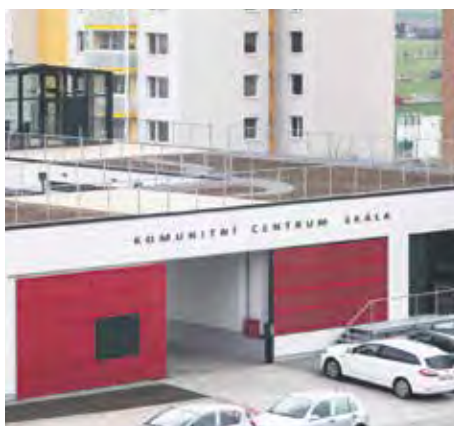
Aktuálně | Výměníkovou stanici v Novém Lískovci nahradilo komunitní centrum
