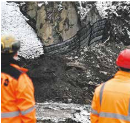
Magistrát informuje | Na Žabovřeské provedli zkušební odstřel tramvajového tunelu
