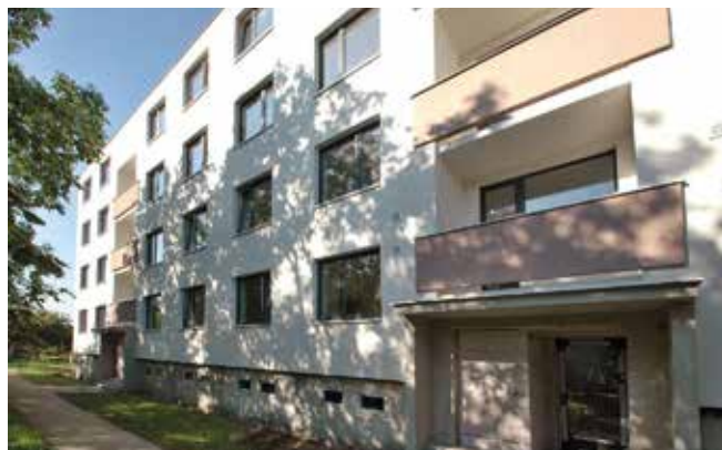
Investiční byty v zrekonstruovaném domě v Brně-Chrlicích.
