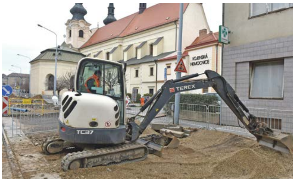
U Vojenské nemocnice v prosinci začaly práce na vodovodním řadu a kanalizaci. Foto: Z. Kolařík
