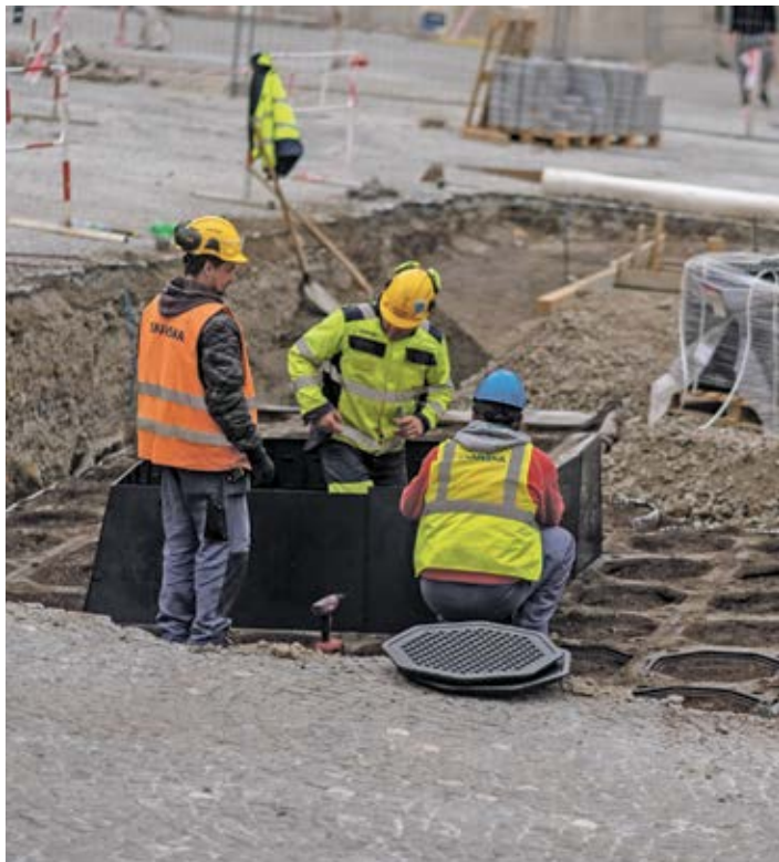
Na Dominikánském náměstí budou vysazeny stromy do speciálních prokořenitelných buněk, které jsou umístěny pod povrchem. Foto: M. Malíková, KAM Brno
