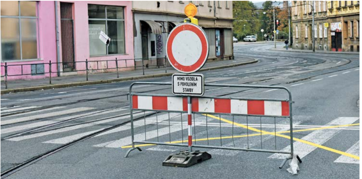
Zábrdovická ulice je od října neprůjezdná. Pracuje se na její kompletní rekonstrukci. Foto: Z. Kolařík
