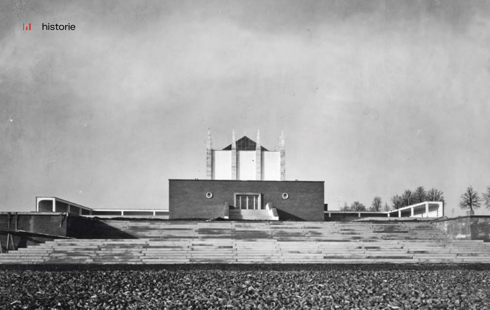
Pohled na průčelí městského krematoria, kolumbárium a hlavní schodiště. Snímek byl pořízen 7. ledna 1930. Foto: Archiv města Brna
