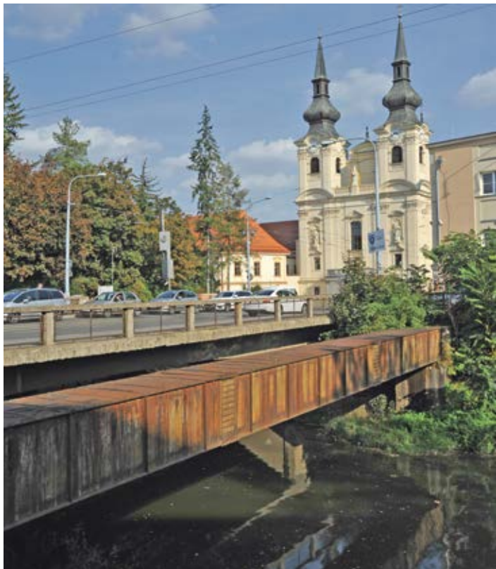
Most v Zábřdovicích čeká generální oprava. Foto: Z. Kolařík
