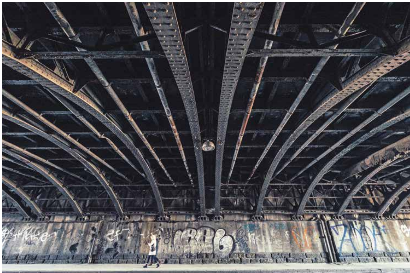
Pod kolejemi. K železničnímu uzlu patří i okolní mosty a stavby, které jsou dokladem technologické zručnosti našich předků. Foto: KAM Brno / Simona Zpěváková
