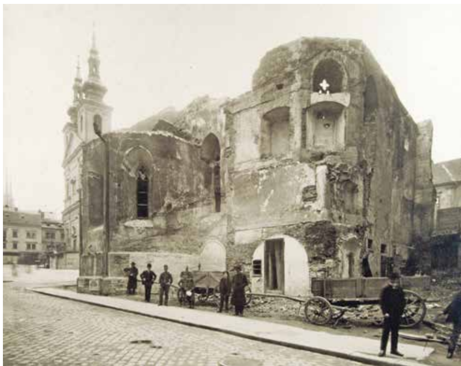
V severní části Dominikánského náměstí stála královská kaple. V roce 1908 ji město zbouralo. Foto: Archiv města Brna
