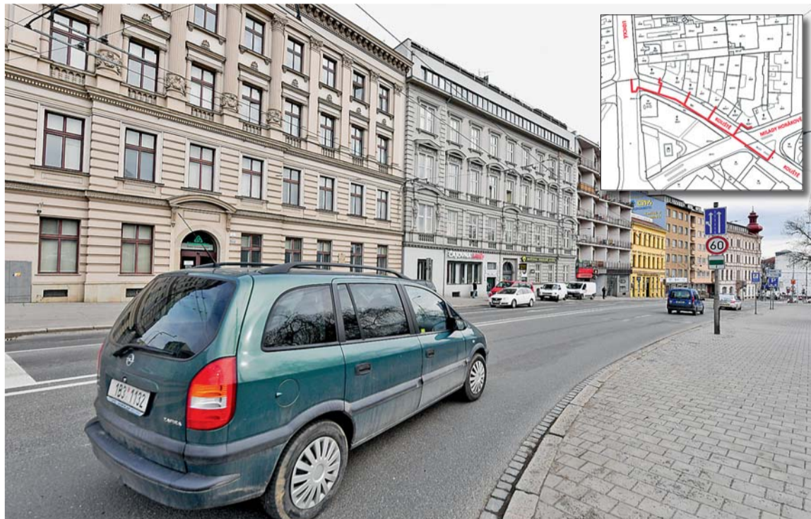
▲ Opravy. Koliště čeká v létě uzavírka, Teplárny budou rekonstruovat horkovody.
