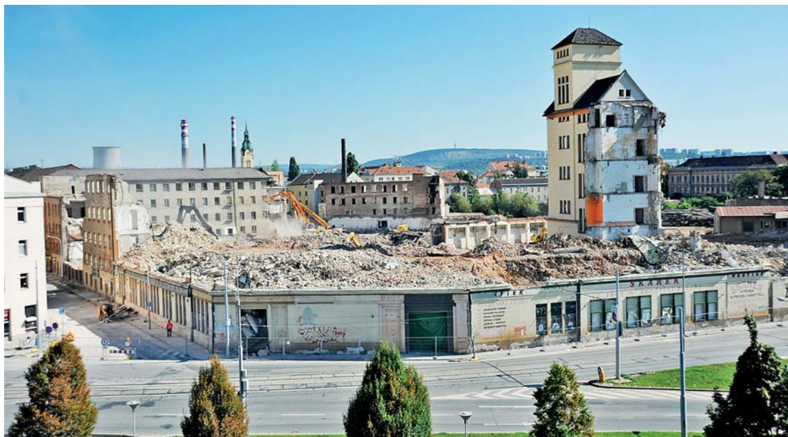
Demolice. V létě začalo bourání bývalé Vlněny. FOTO: Z. KOLAŘÍK
