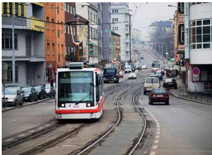
Chystá se oprava kanalizace, kolejí, vozovky i chodníků. Foto: DPMB
