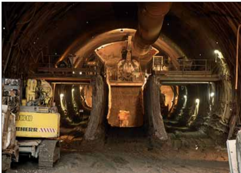
Ražba obou tubusů probíhala v letech 2008–2010. Foto: MMB
