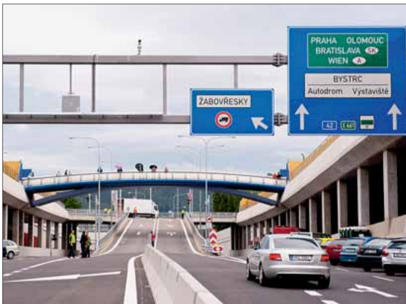
■ Kromě vybudování tunelu byla součástí stavby VMO Dobrovského B i výstavba mimoúrovňových křižovatek a mostů. Foto: M. Schmerková
