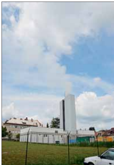
■ Technologické centrum Královopolského tunelu sídlí v prostoru ulic Dobrovského a Slovinská. Foto: MMB
