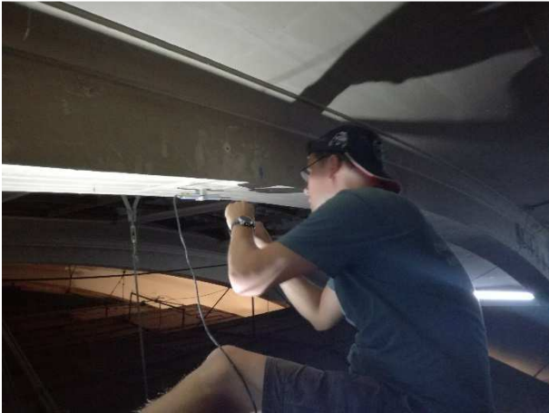
Instalace snímače DH15 ve stropním vazníku
