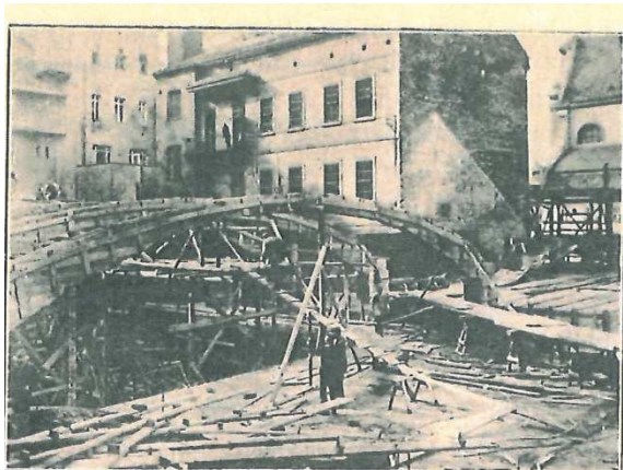
Bednění obloukové střechy nad slavnostním sálem.
