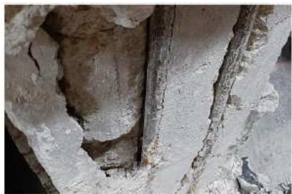
Obr.22-25 : Po odstranění omítky se ukázal celý rozsah poškození sloupu v sondě S5J, kde hlavní výztuž v čele sloupu je i z částí betonu vytržena (vyboulena) směrem do prostoru divadla. Za zmínku stojí i nulové krytí výztuže, které souvisí s absencí třmínků. Je zcela odtržena čelní strana sloupu s výztuží až do výšky 1200 mm nad podlahou, z této strany se odděluje se dvojice vodorovných trhlin napříč sloupem ve výšce cca 750 mm nad podlahou.
