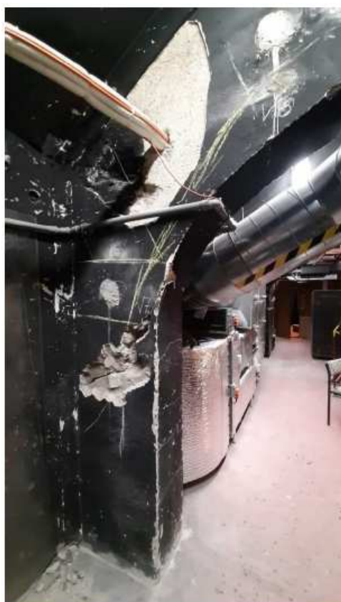
Obr.11 : Celkový pohled na místo sondy S5M spolu s vykreslením polohy trhlin a výztuže jasně ukazuje, že průběh trhliny souvisí se způsobem vyztužení, a velkou roli hraje poloha třmínek ve sloupu.
