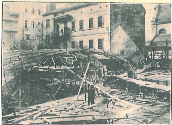
Bednění obloukové střechy nad slavnostním sálem.
