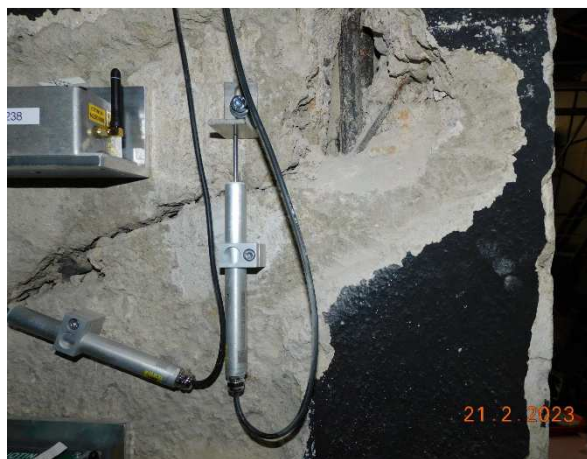
Foto z instalace 21.2.2023, detail snímače DH15
