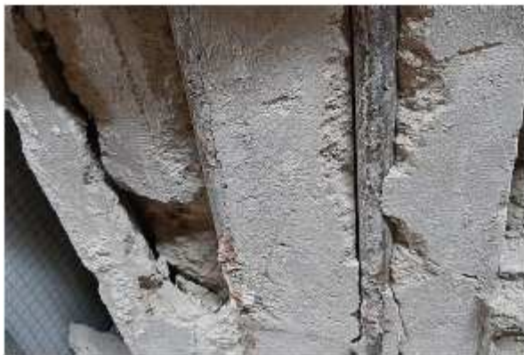
Obr.22-25 : Po odstranění omítky se ukázal celý rozsah poškození sloupu v sondě S5J, kde hlavní výztuž v čele sloupu je i z částí betonu vytržena (vyboulena) směrem do prostoru divadla. Za zmínku stojí i nulové krytí výztuže, které souvisí s absencí třmínků. Je zcela odtržena čelní strana sloupu s výztuží až do výšky 1200 mm nad podlahou, z této strany se odděluje se dvojice vodorovných trhlin napříč sloupem ve výšce cca 750 mm nad podlahou.
