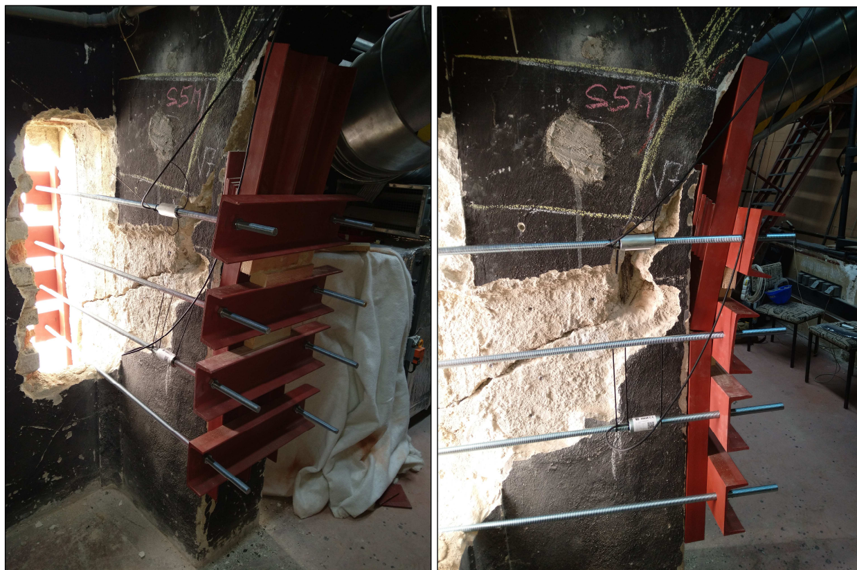
Obr.18-19 : Provizorní statické zajištění jednoho ze sloupů v rámu 5. ocelovými prvky spojenými závitovými tyčemi, s osazenými měřiči deformace.
