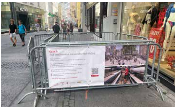
V první fázi se pomocí kopaných sond ověřují polohy inženýrských sítí. Foto: Radka Loukotová
